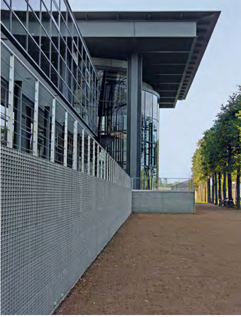
Kaynaklı paslanmaz çelik ızgara, Fransız kenti Sélestat'daki Mediathèque üzerinde güneş gölgesi olarak kullanılmıştır.
