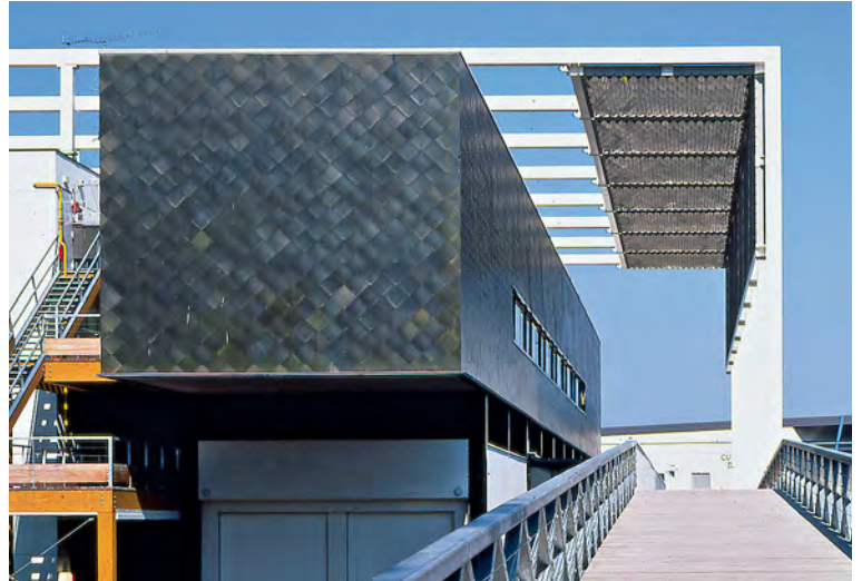
Kaynaklı paslanmaz çelik ızgara, Fransız kenti Sélestat'daki Mediathèque üzerinde güneş gölgesi olarak kullanılmıştır.
